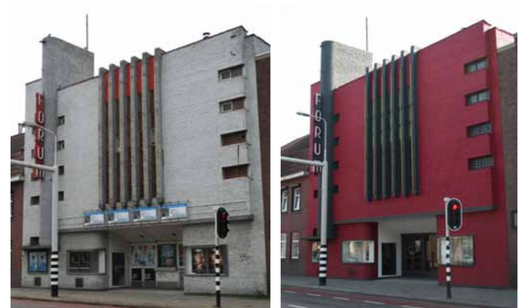
Na een lange tijd van leegstand is de voormalige Forum-bioscoop na een grondige renovatie weer in gebruik genomen. Het complex is een rijksmonument, ontworpen door architect Jos Wielders.
