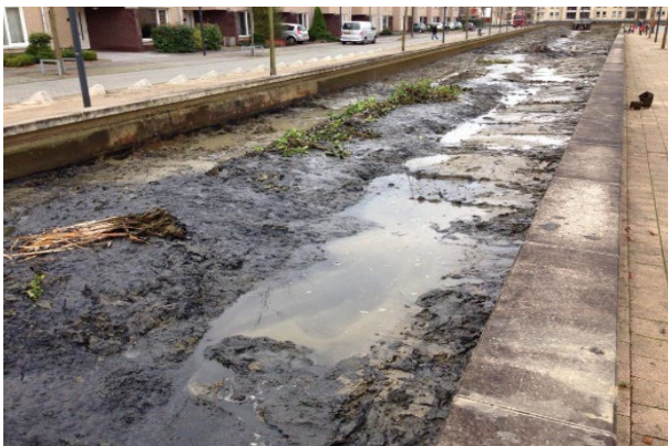
Foto: Vijver Aldenhof baggerwerk
