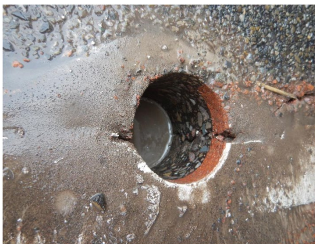
Boorkern(en) ten behoeve teerhoudend asfalt.
