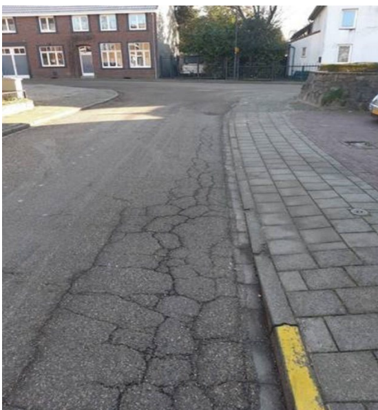
Randschade/scheurvorming.
