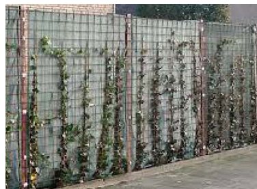
Tijdelijke bespanning met winddoek in grijze (rustige) kleur en begroeid gaaswerk
