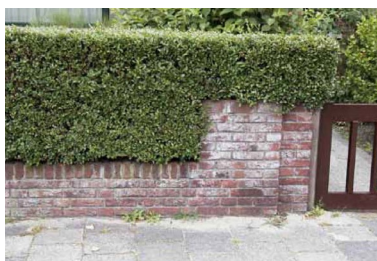
Metselwerk gecombineerd met begroeiing
