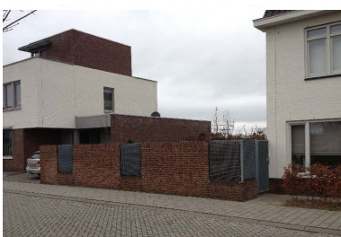
Metselwerk gecombineerd met metalen rasters
