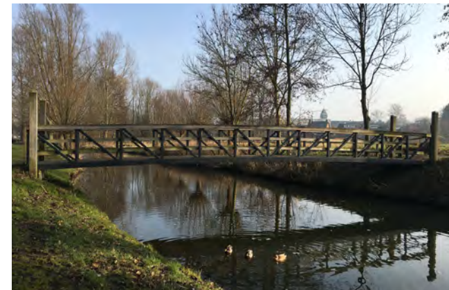
De bestaande voetgangersverbinding over de beek
