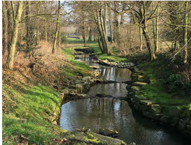
De hoogwaterverbinding en vistrap
